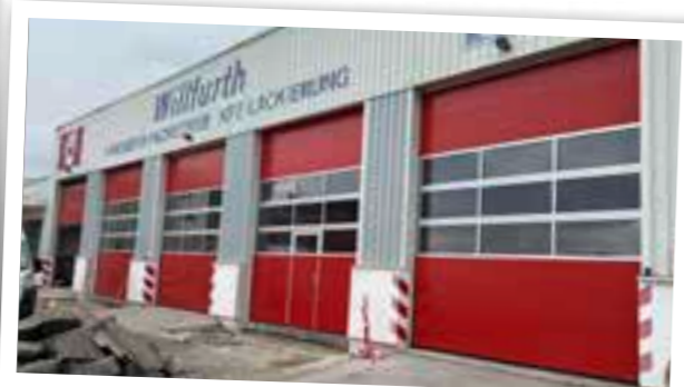
Der Umbau der Brunner Feuerwehr geht voran – die roten Tore sind bereits eingebaut. Der Rest schon weit fortgeschritten.
