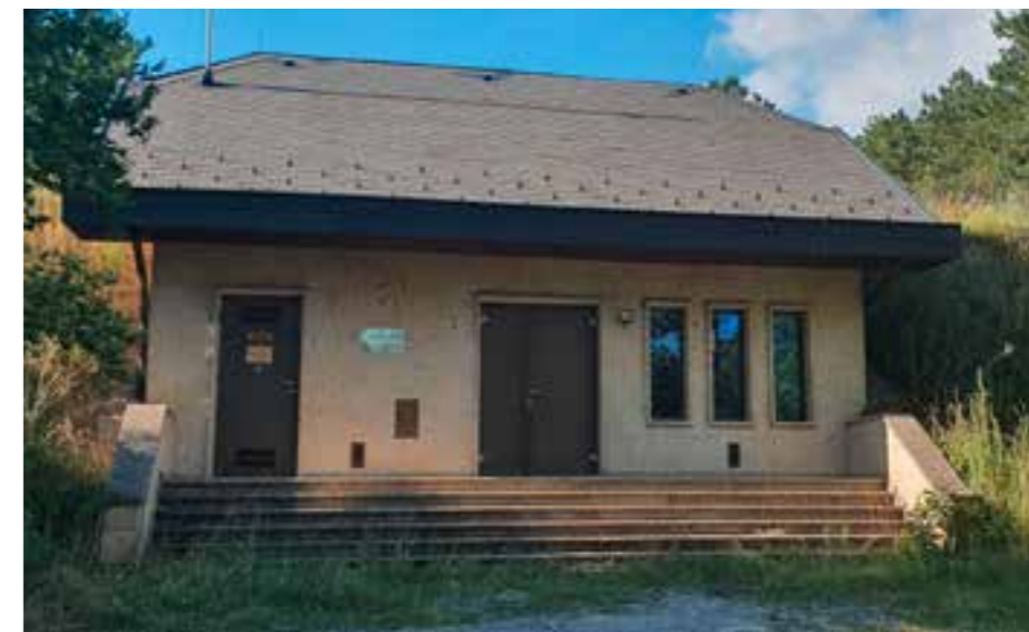
Der Hochbehälter mit einem Fassungsvermögen von 3.600 m³
